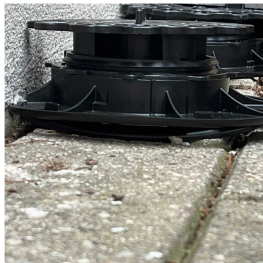
Opkiling af terrassefodderne vha. plaststykker
